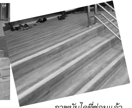
ภาพบันไดที่ซ่อมแล้ว
