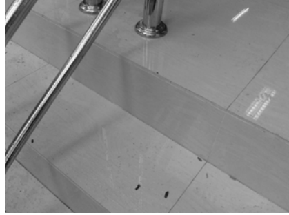
บันไดก่อนซ่อม
